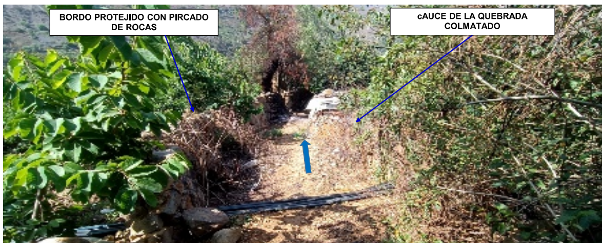
FIGURA N°03: TRAMO DE LA QUEBRADA HUAYOPAMPA SE ENCUENTRA COLMATADO CON SEDIMENTOS, EN PARTES HASTA EL NIVEL DE LAS AREAS DE CULTIVO, PONIENDO EN RIESGO A DESBORDE HACIA LAS ÁREAS DE CULTIVOS Y HACIA LAS VIVIENDAS DEL C.P. HUAYOPAMPA
